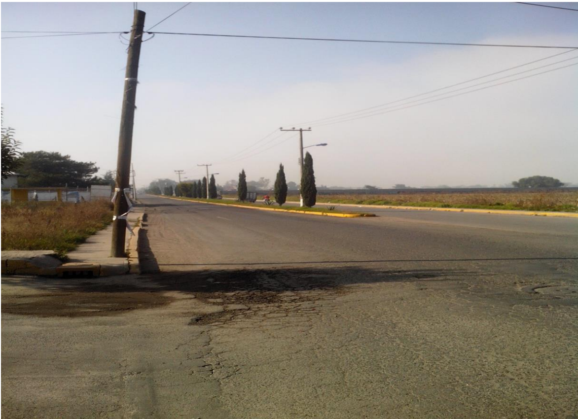
Acceso Carretera Jaltenco-Nextlalpan-Zumpango Av. Comercio Industrial
