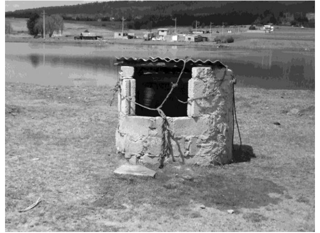
Figura 6. Pozo de la familia Ríos en el Ejido El Sitio, con brocal, cubierto y con garrucha.
