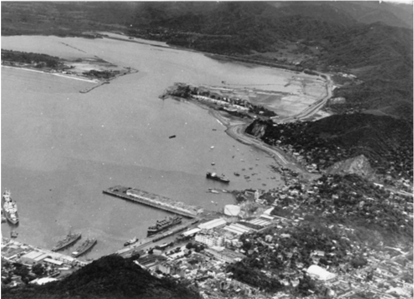
Figura 1. Obras de dragado del puerto interior, 1970.
