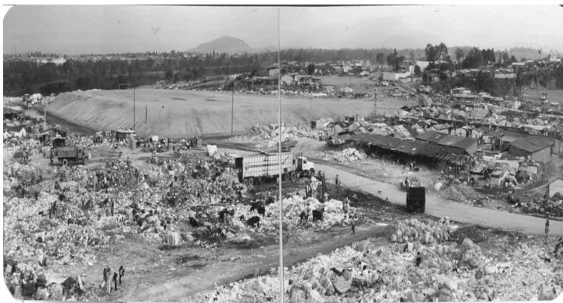
Figura 3. Tiradero de Santa Fe, década de 1980. En la imagen se observa: casas de los pepenadores, camiones de redilas y transfers, bolsas de azul (son empaque de residuos hospitalarios) y el desnivel se refiere a los inicios del saneamiento del tiradero.
