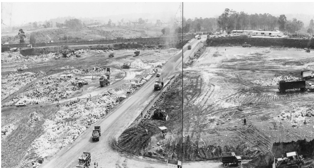
Figura 5. Panorámica del relleno sanitario Prados de la Montaña.
