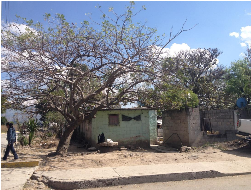
Fotografía 5. Vivienda con material duradero sin terminar
