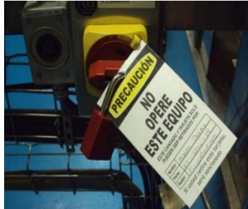
Figura 4.8 Paso 4: fuente bloqueada y etiquetada
