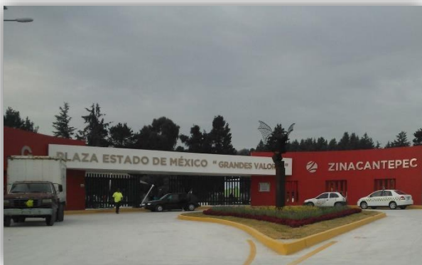
Fotografía 9. Construcción de una unidad deportiva (Fuente:Elaboración propia).
