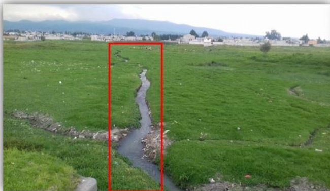
Fotografía 1. Canal de aguas residuales que atraviesa el bordo (Fuente:Elaboración propia)
