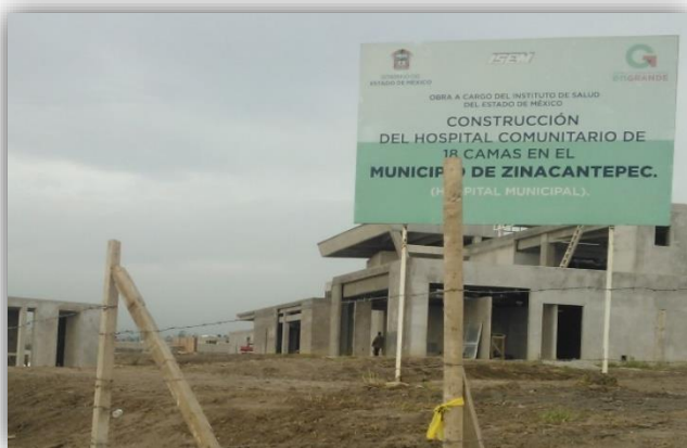
Fotografía 7. Construcción de un hospital (Fuente:Elaboración propia).
