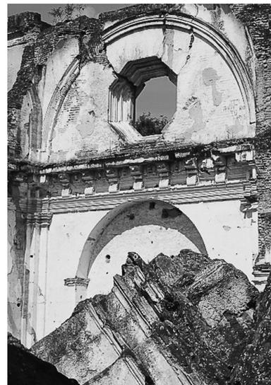
» Imagen 2: Estado de destrucción en muros y presencia de grietas Fotos H. Serrano.
