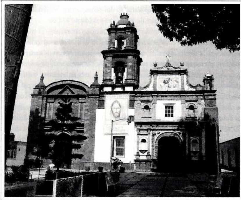
Figura 6. Fachada de la iglesia de Tlacotepec. (Fotografía de René García).
