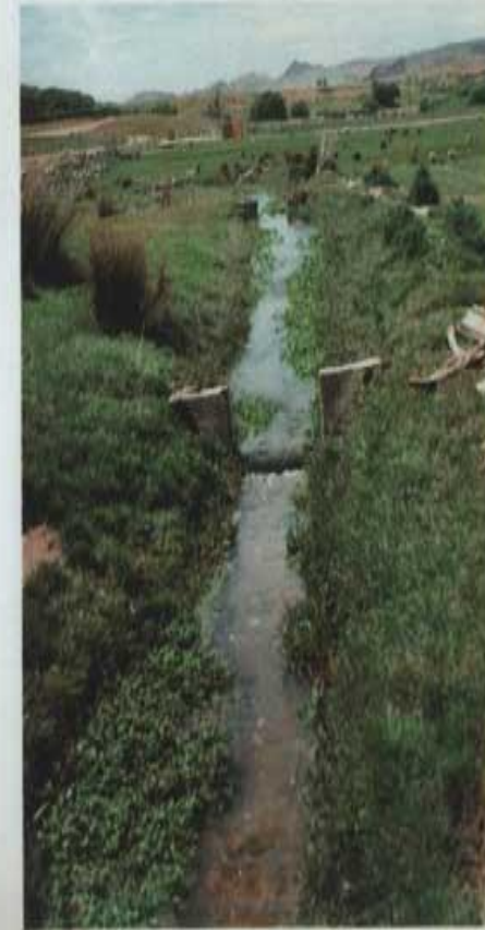
Figura 9 Canal de drenaje.
