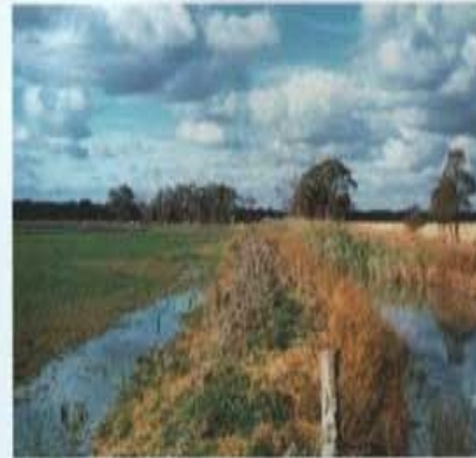
Figura 7 Escape de un canal de riego.
