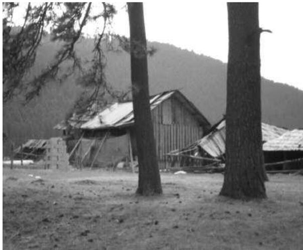
**Fotografía 2.** Vivienda con techo de lámina y muros de madera.
