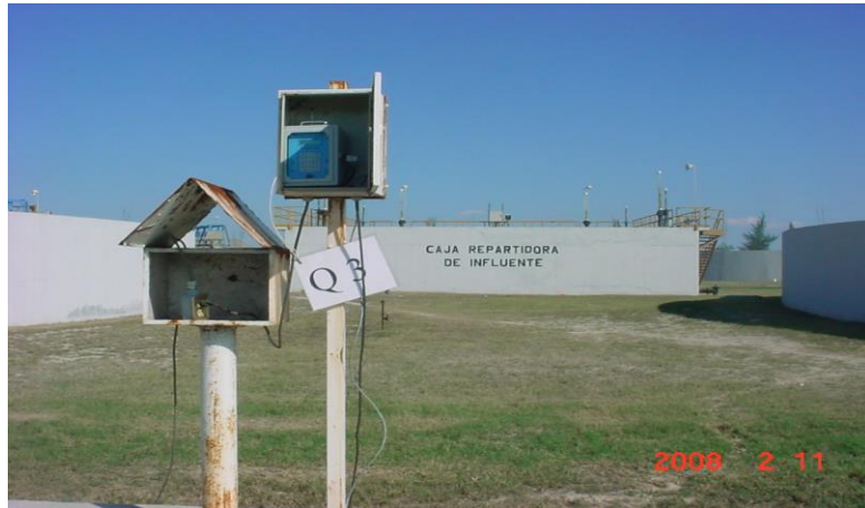
Punto de medición de influente crudo ( Q_3 ). Medición tipo doppler.
