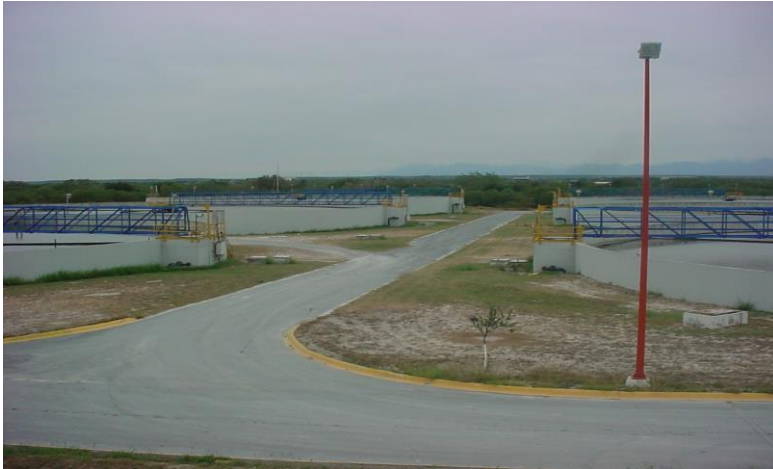
Sistema de clarificadores secundarios (6 unidades CS 1 a CS 6 )
