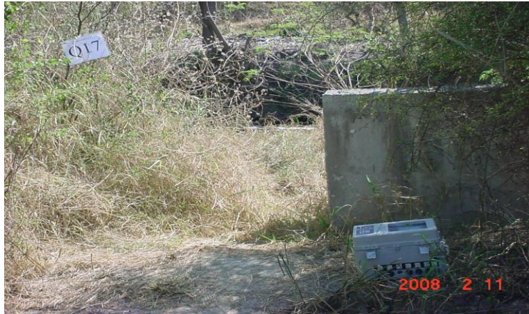
Medidor área-velocidad (efluente agricultura, Q 17 ). Flujo en canal.
