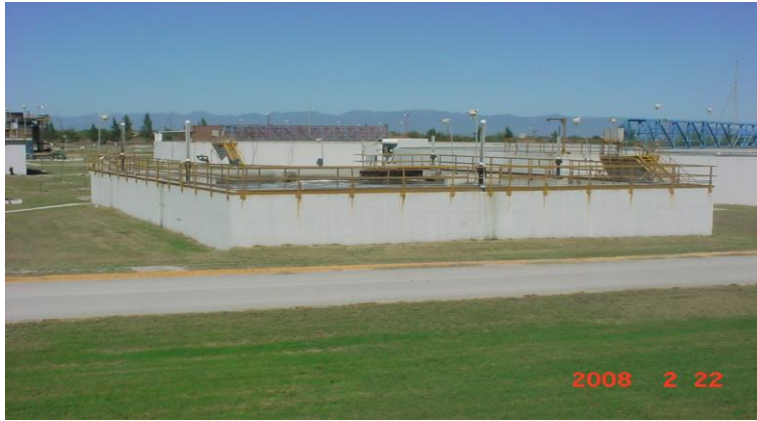
Caja repartidora de influente a reactores (CR 2 )
