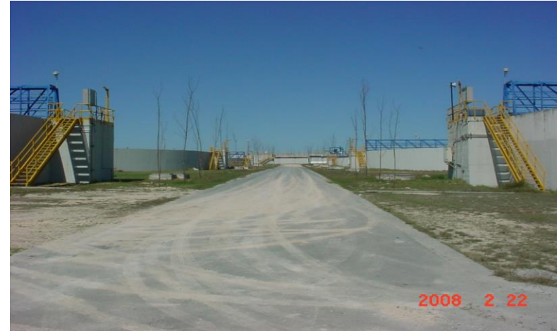
Otra toma de los CS, al fondo la plataforma de los reactores
