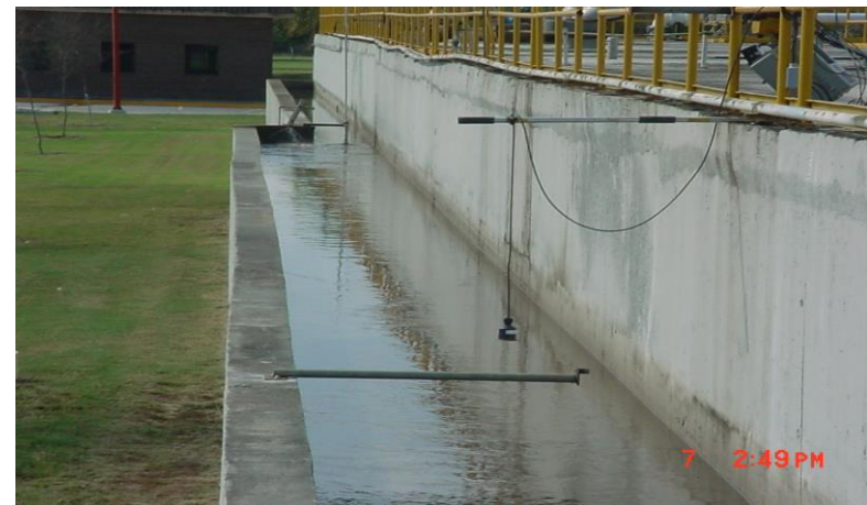
Al fondo sensor de velocidad en efluente de R_1 y en primera instancia sonda ultrasónica en efluente de R_2 .
