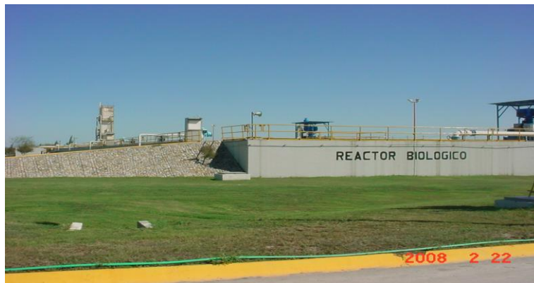
Sistema de reactores biológicos (tren de 5 reactores R 1 a R 5 )
