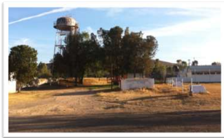
Imagen 11. Tanque elevado de la granja SEDENA.
