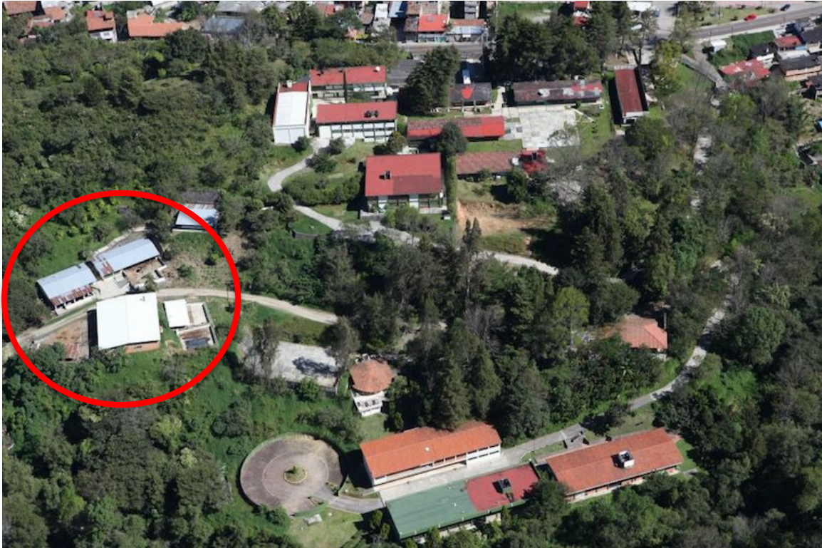
Figura 1. Vista aérea del Centro Universitario UAEM Temascaltepec. En círculo se indica la ubicación de la Posta.
