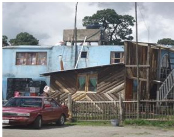
Imagen No. 3 Vivienda Modificada
