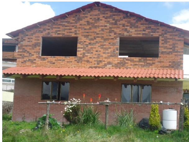
Imagen No. 5 Viviendas con Fachada Modificada
