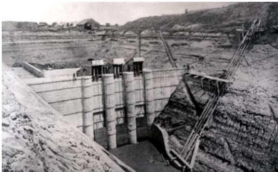
Imagen 7. Presa y compuerta del Gran Canal de Desagüe
