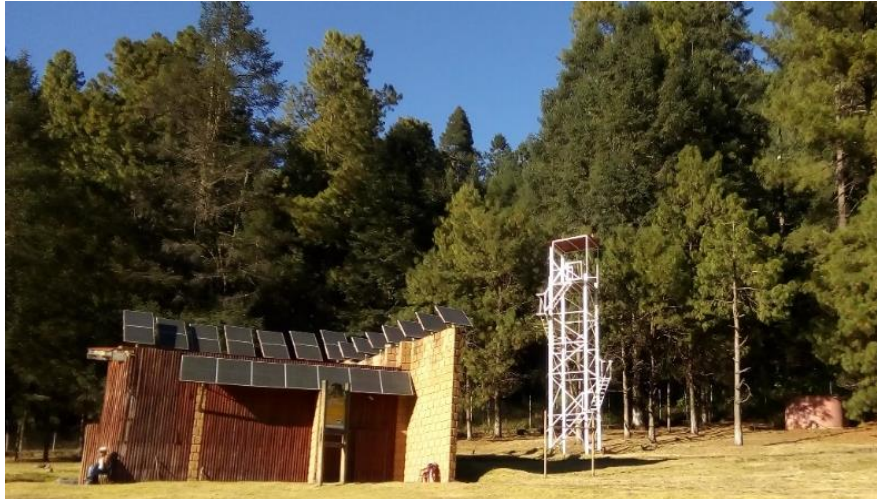
Infraestructura que anteriormente la utilizaban como una sala para dar platicas sobre la mariposa monarca. A lado se puede observar la base de una tirolesa.
