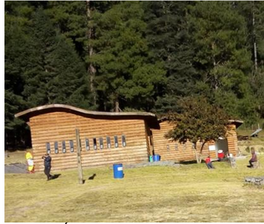
Área de Sanitarios
