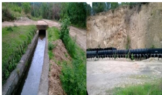
Figura 2: Sustitución del canal
