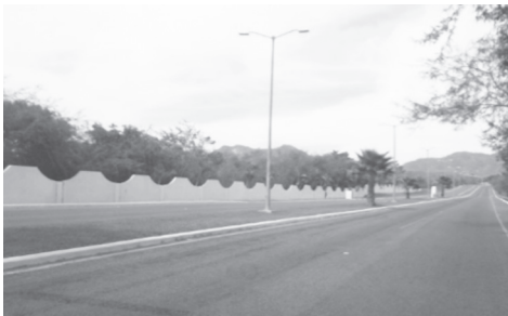
Figura 3. Muro perimetral del CIP Litibú
