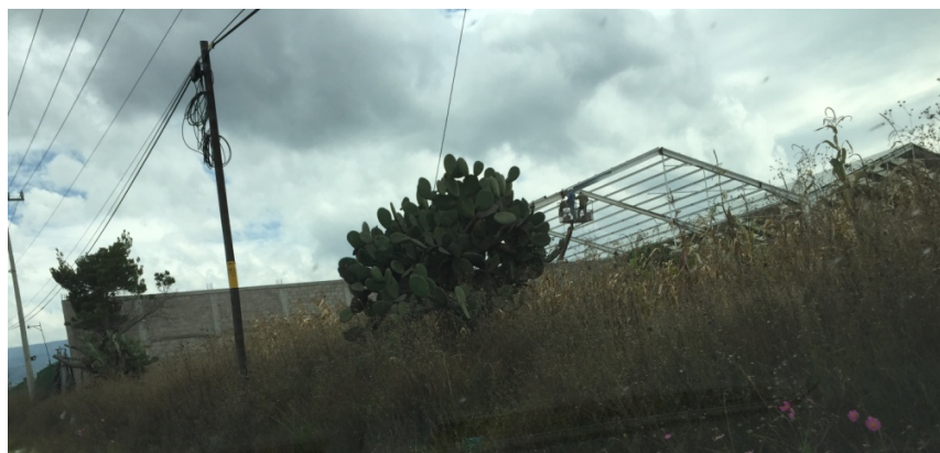
Figura 28. Construcción de nave industrial para fabricación de asientos de aeronaves en una localidad del municipio
