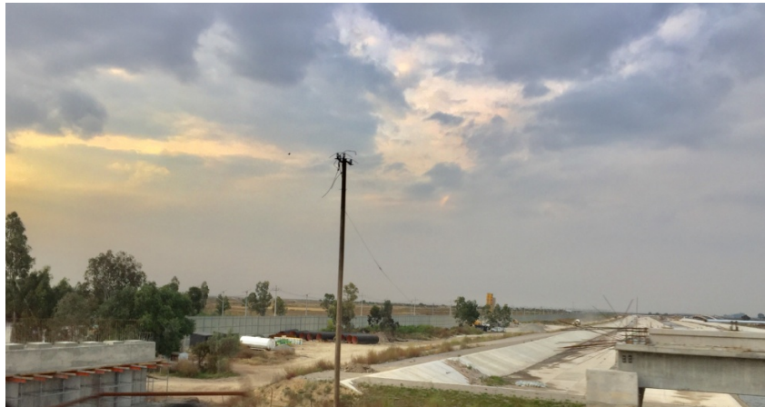
Figura 18. Obras carreteras en el vaso del Ex Lago de Texcoco
