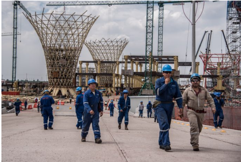
Figura 11. Trabajos temporales durante la construcción del NAIM
