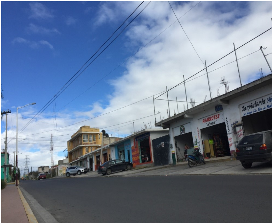
Figura 13. Pequeños comercios de reciente apertura cercanos a una intersección de camiones de carga
