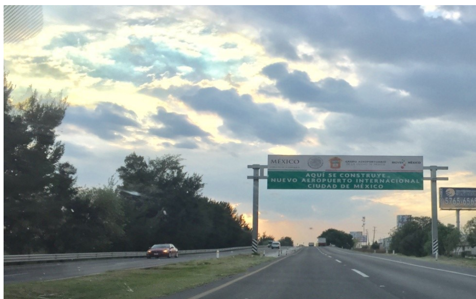
Figura 12. Autopista Peñón-Texcoco y la construcción del NAIM
