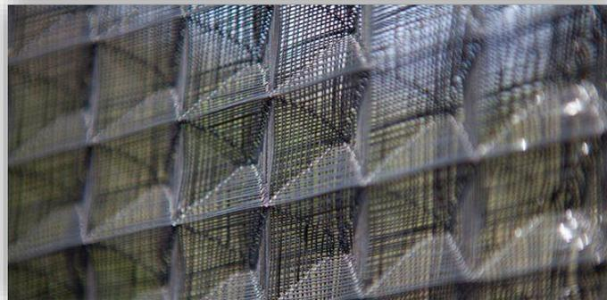
Figura 2 Atrapanieblas o captanieblas sistema capaz de captar gotas microscópicas.
