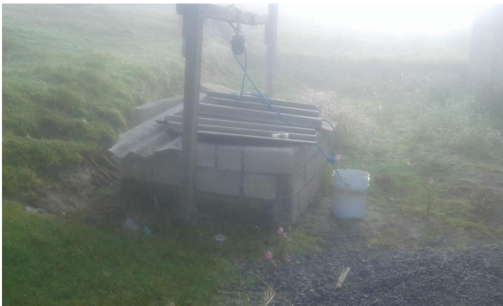
Imagen 5.1 Provisión de agua potable mediante un pozo familiar. 2017.
