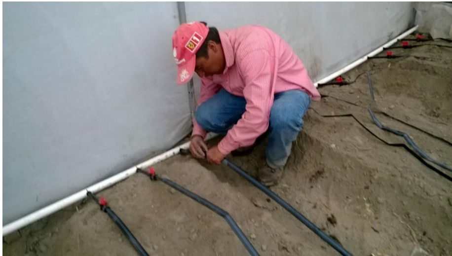
Figura 8. Instalación del sistema de riego.
