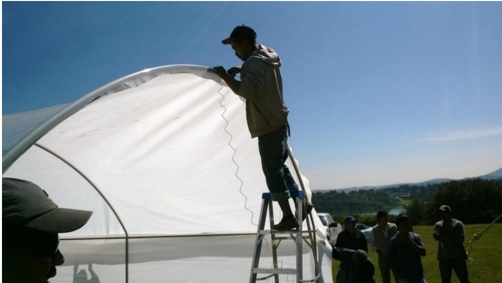
Figura 6. Fijación de la tapa del invernadero con alambre Zigzag.
