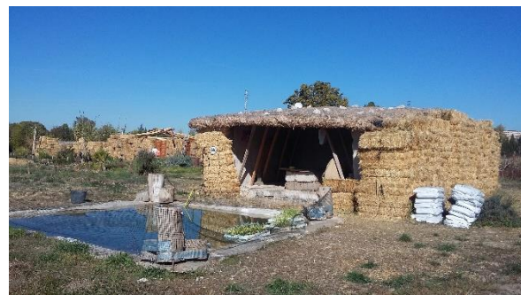
Figura 4.15 Taller de Bioconstrucción y estanque de hidroponía para producción de alfalfa y lechuga Fuente: Autoría propia
