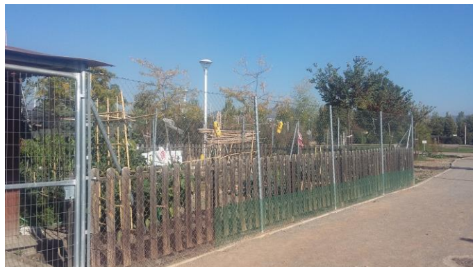
Figura 4.9 Sistema de vallado observado en ambas zonas de cultivo, malla metálica sobre cerca de madera Fuente: Autoría propia
