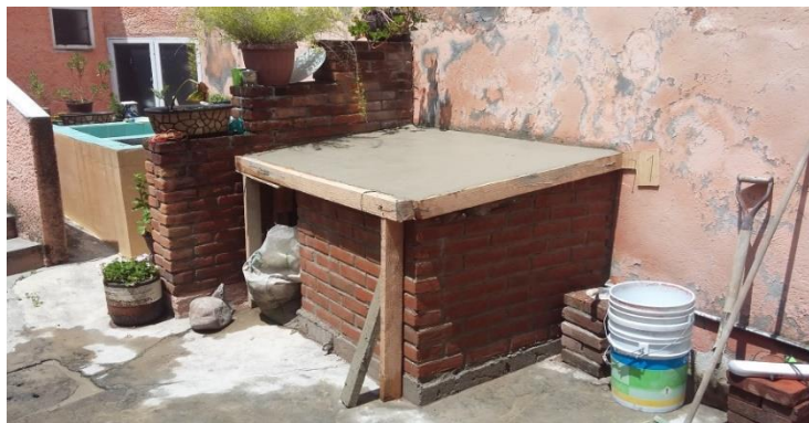
Figura 4.26 Construcción de casa para perro, con cajón de cultivo en la parte superior
