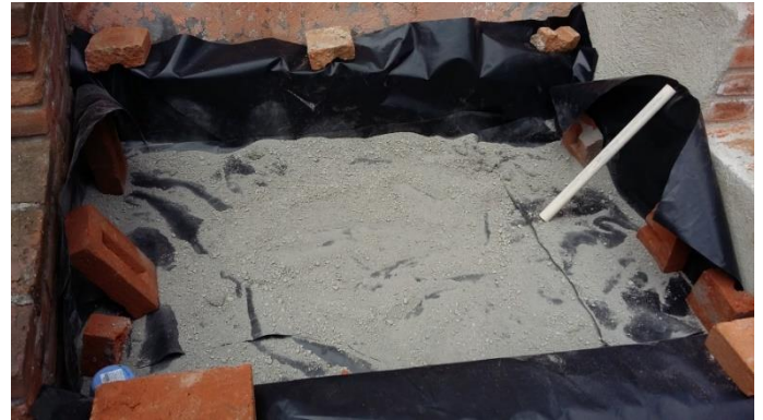
Figura 4.27 Colocación de capas de plástico negro para proteger loza de humedad. Y figura 4.28 colocación de capa de arena
