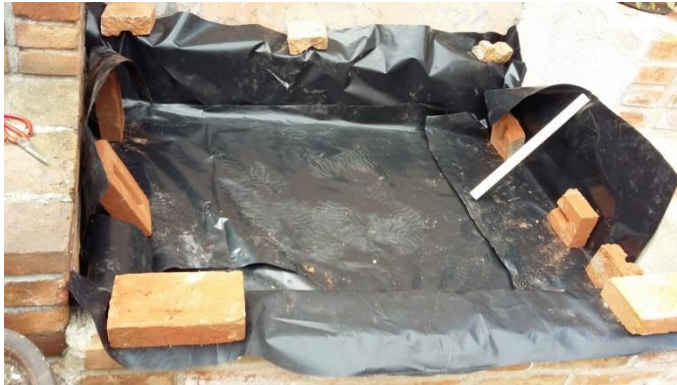
Figura 4.27 Colocación de capas de plástico negro para proteger loza de humedad. Y figura 4.28 colocación de capa de arena
