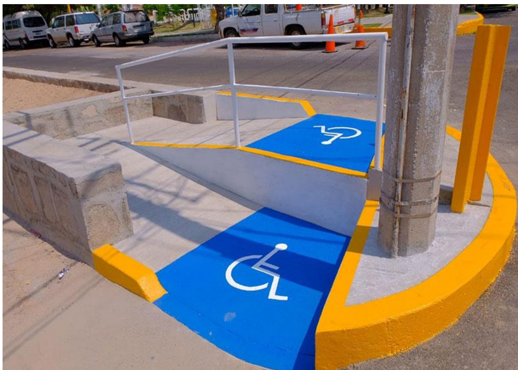
Figura No. 50: Rampas en banqueta.
