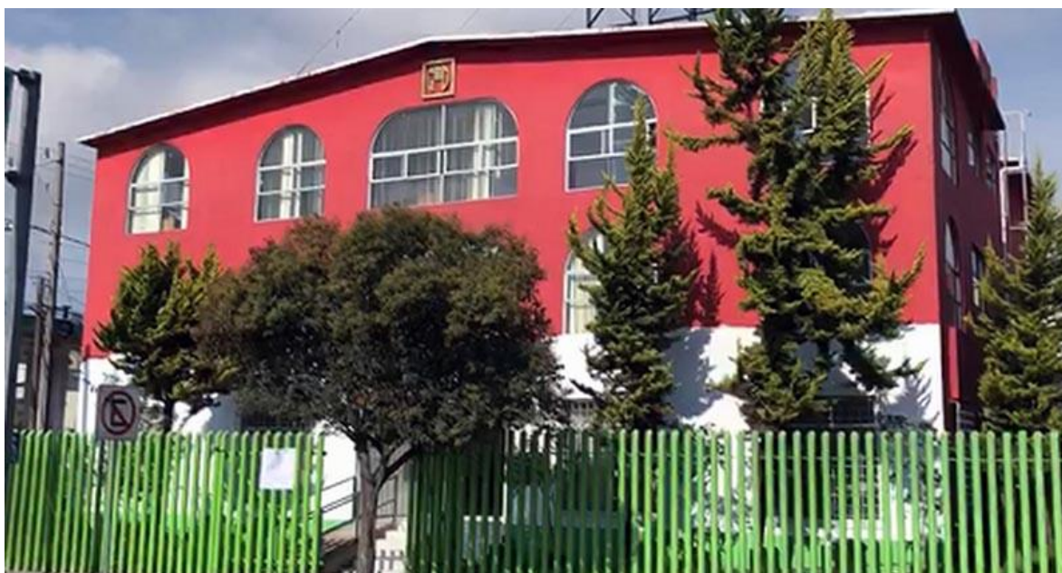
Figura No. 13: Edificio Gubernamental.
