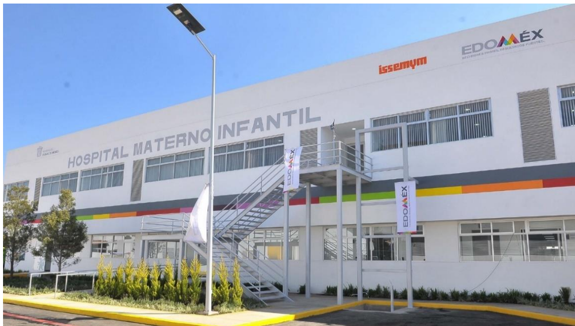
Figura No. 25: Vista desde el estacionamiento interior del HMI de Toluca.
