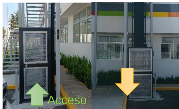
Figura No. 45: Montacargas exterior sin accesibilidad adecuada.
