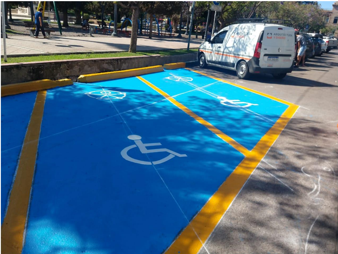
Figura No. 70: Señalización en estacionamientos.
