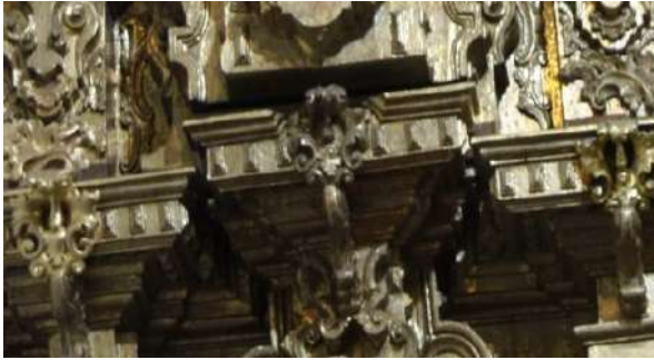
Imagen 59. Vista de la unión entre el segundo y tercer cuerpo.
