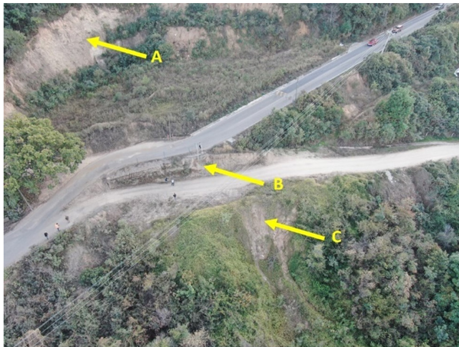
Figura 11. Deslizamiento ocurrido en Totolmajac, Villa Guerrero
