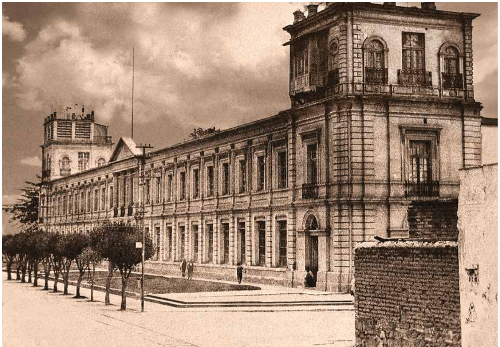
Imagen 10. Fachada concluida, primer y segundo torreón del Edificio Histórico de Rectoría, 1915
