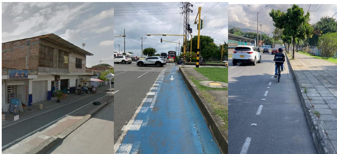
Imagen 15. Tipos de Ciclo-rutas construidas en Cali según su ubicación en el carril
