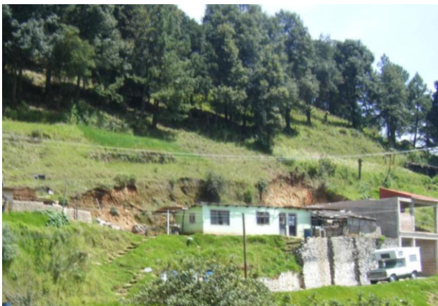
Foto 51 y 52: Zonas de humedad.
