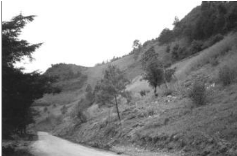
Foto 2: Deslizamiento Traslacional. Fuente: Grupo de trabajo Mi Ladera (2001).
