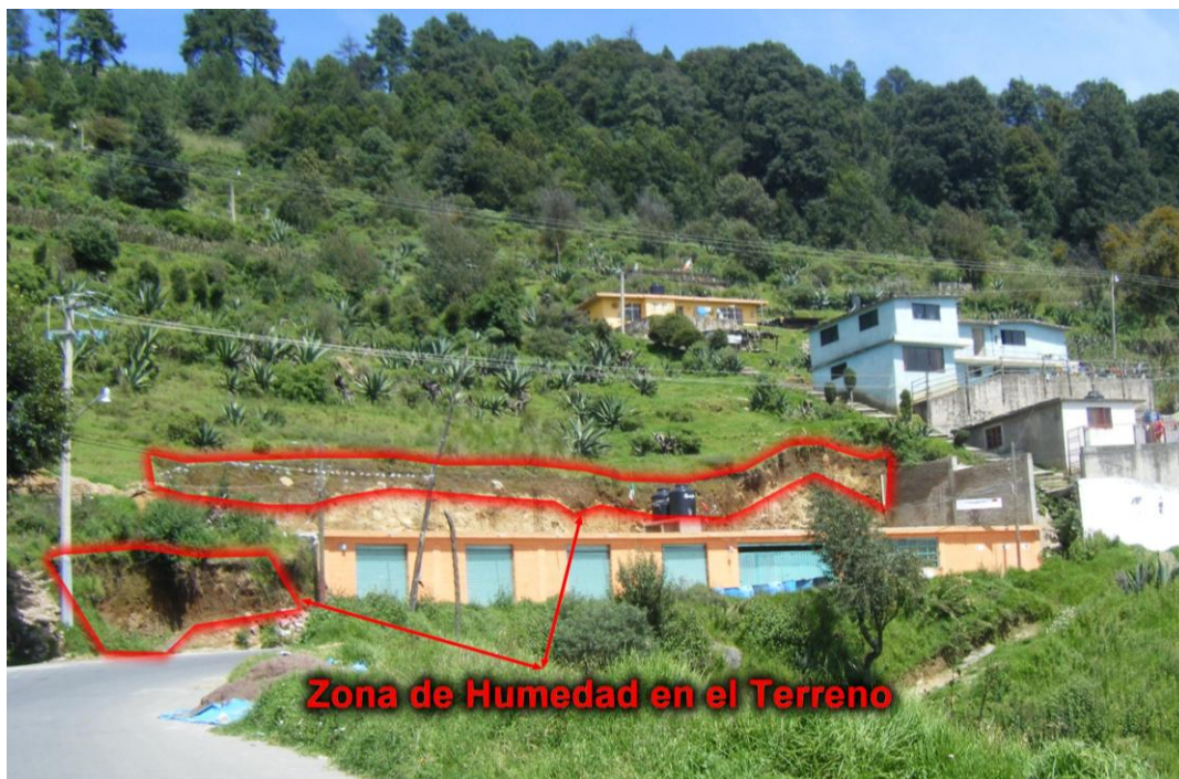
Foto 24: Zona de humedad(Pc 70).
