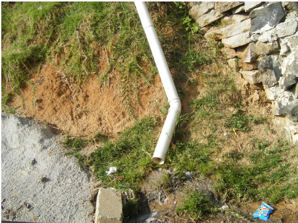
Foto 4: Disposición del drenaje hacia la calle.
