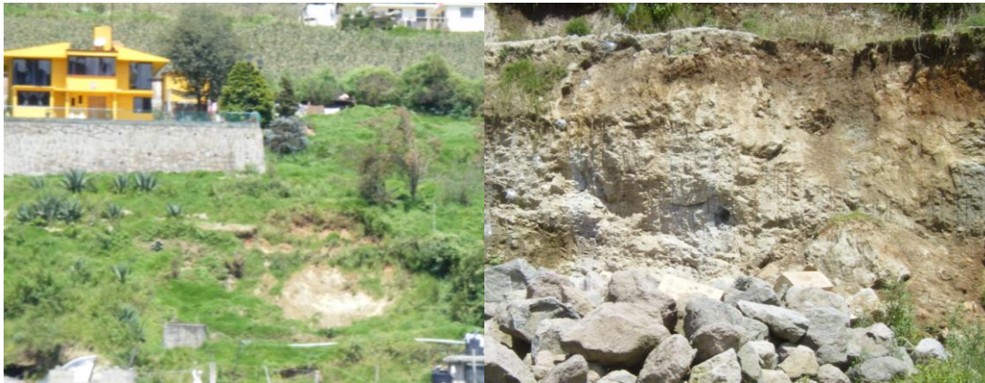
Foto 67: Movimiento antiguo. Foto 68: Zona de debilidad. Lugar: Zona Teco, Santa Cruz Ayotuxco.
