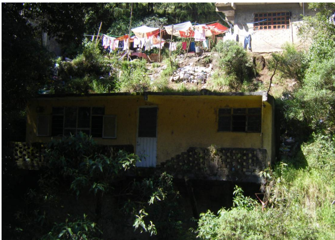
Foto 13: Asentamiento y deslave (Pc 35).
