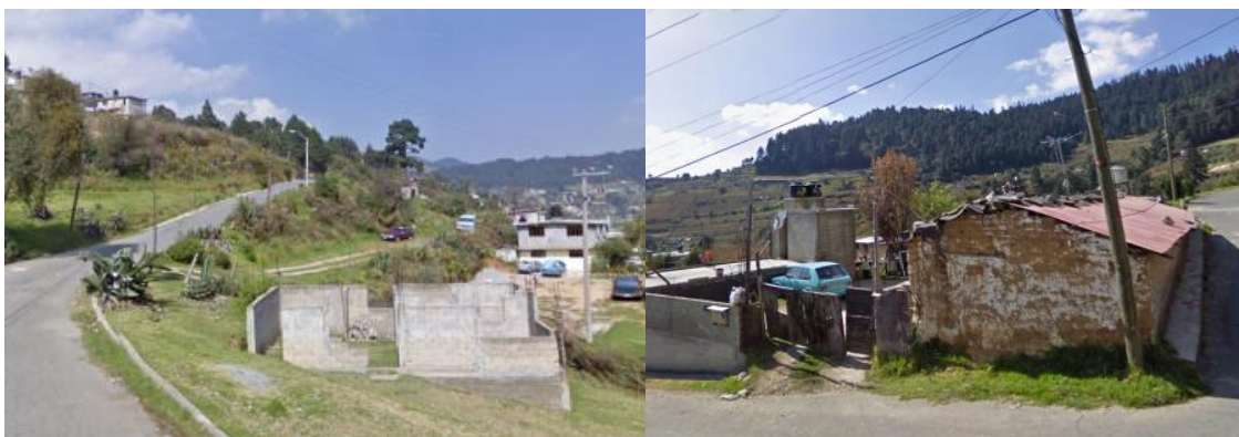
Foto 54 y 55: Materiales en la vivienda.
