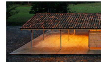
Figura #24 Cubierta a dos aguas de teja.
