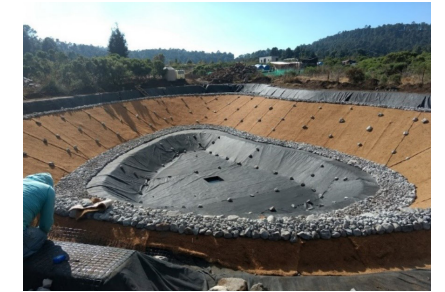
Figura #109 Construcción de Lago.
