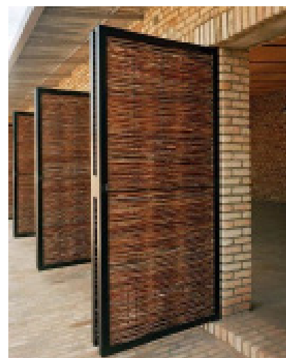
Figura #20 Muro de BTC
