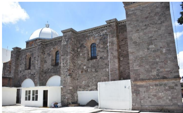
Imagen 3.1.1.3. Fachada Lateral-Norte. (Huerta K. 2018)
