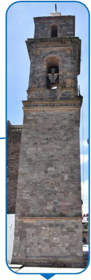
Vista completa del campanario descrito en la imagen: Fachada Este.
