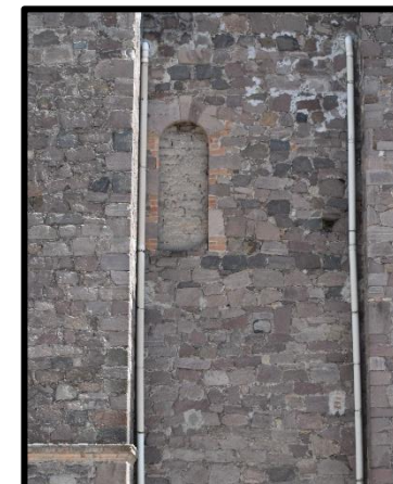
Imagen 1. Ventana sellada e instalaciones de PVC. (Huerta K. 2018)
