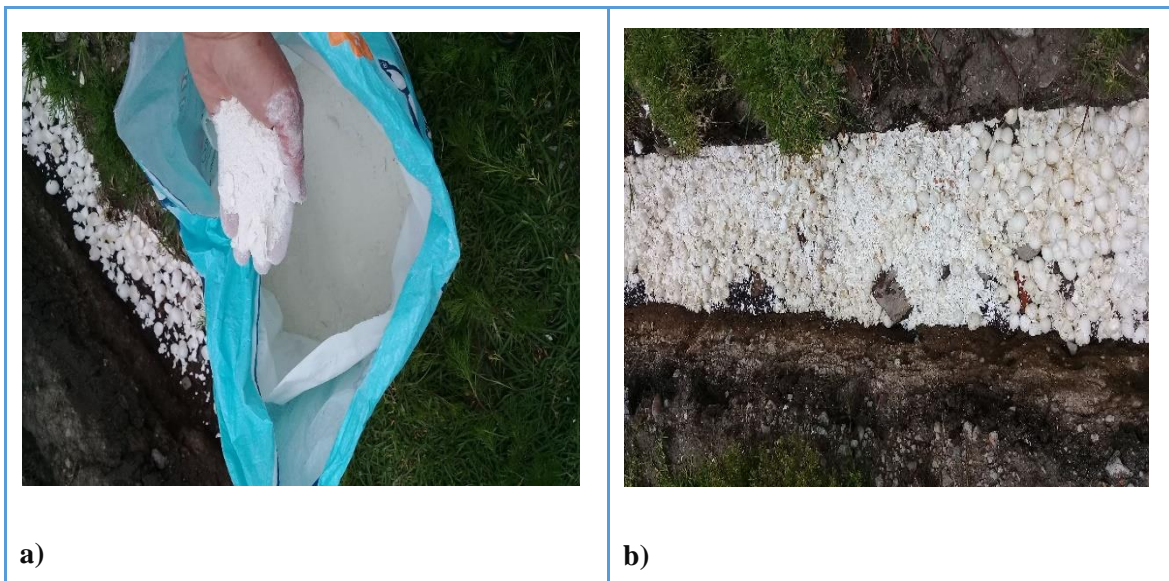
FIGURA 133 A) Y B) INCORPORACIÓN DEL CASCARÓN DE HUEVO EN LA ZANJA CIRCUNDANTE AL POZO A027
