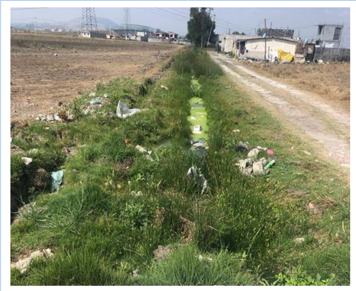
FIGURA 7. ZANJAS DE DESCARGA DE AGUAS RESIDUALES DE LA COMUNIDAD DE SEBASTIÁN LERDO DE TEJADA
