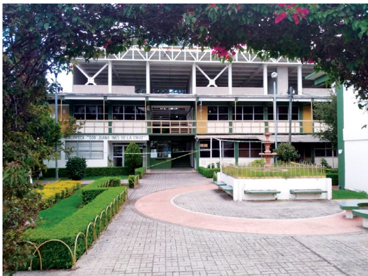
Figura 86. Estado actual del edificio E, áreas acordonadas; obras de ampliación suspendidas
