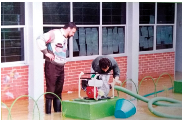
Figura 45. Bombas en acción para desaguar el plantel
