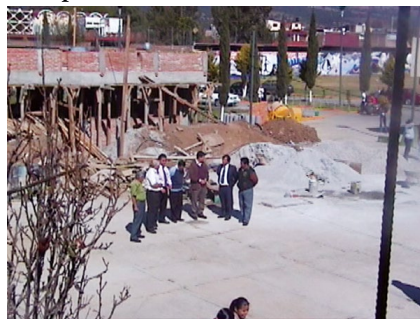
Figura 60. El director, químico Arturo Laguna Tovar, segundo de derecha a izquierda, supervisando la construcción de la dirección
