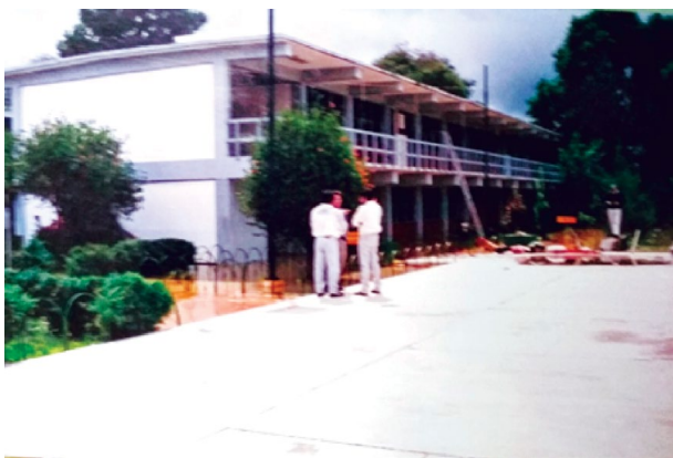
Figura 44. Autoridades revisando los daños causados por la inundación
