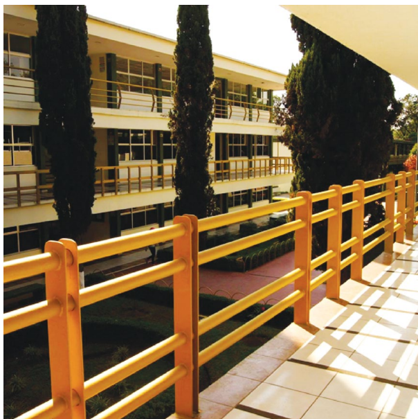
Figura 103. Jardines y pasillo que separa los edificios B y C del plantel PPG
