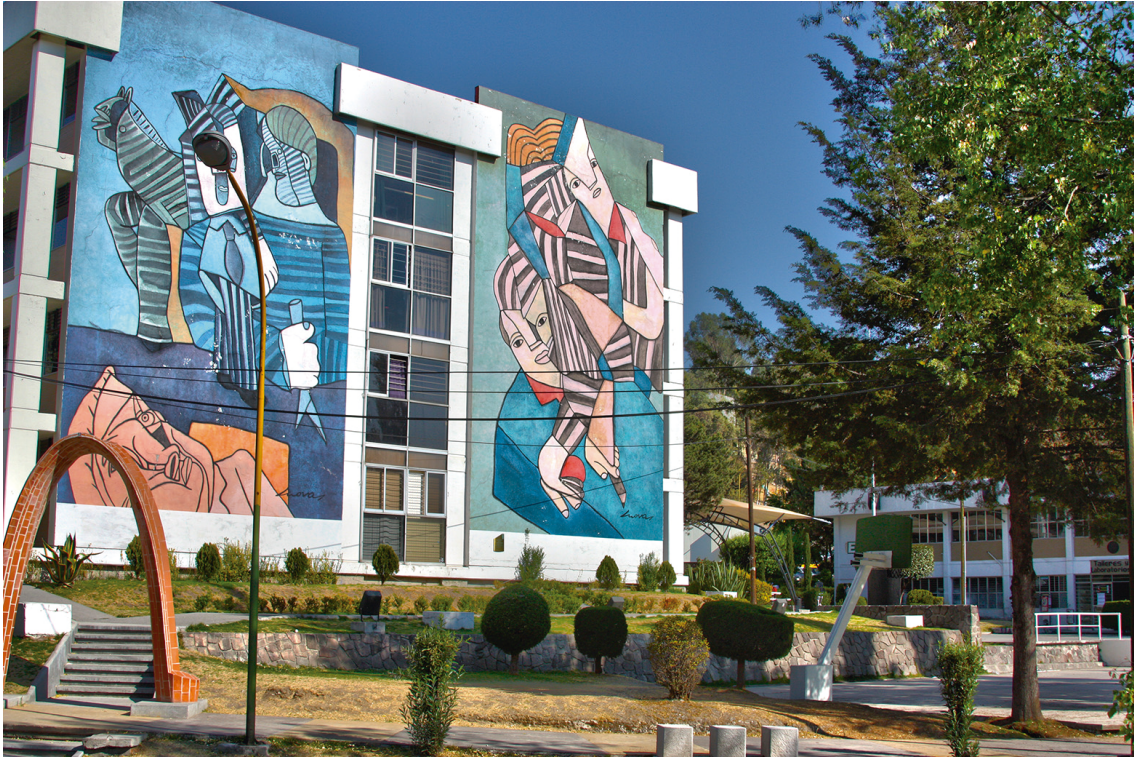
4.2 imagen frontal del edificio B(elaboración propia), el de mayor capacidad y mayor flujo de personas dentro de la FAD.
