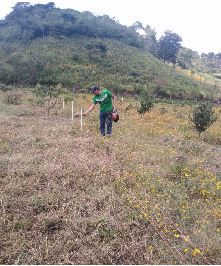
Figura 9 Instalacion del cerco electrico
