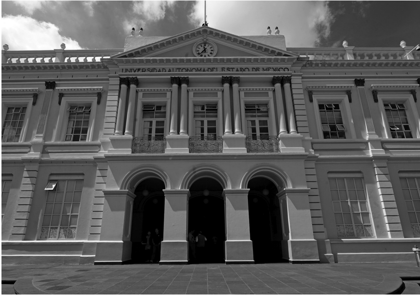
Fachada del edificio de Rectoría de la Universidad Autónoma del Estado de México.
