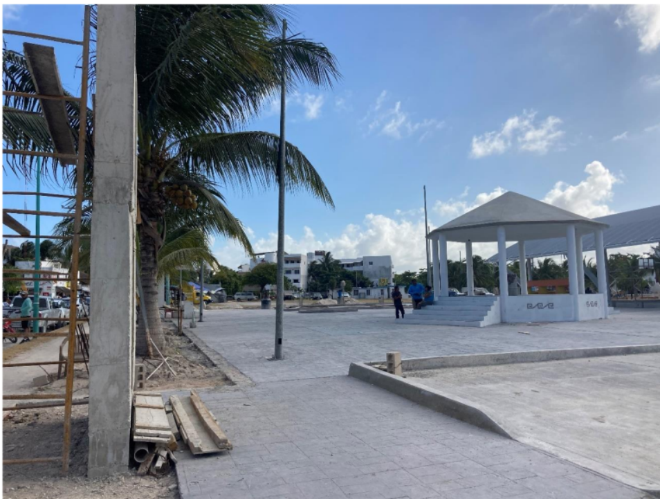
Construcción del Kiosco central de la localidad.
