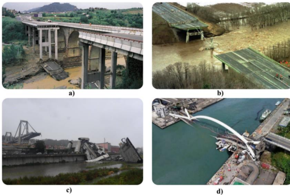
Figura 1.2 Colapso de puentes en el mundo por socavación local, a) Puente Magorola-Esparraguera, España (Ministerio de Fomento, 2010); b) Schharie Creek E.E.U.U. (Swenson y Ingraffea, 1991); c) Viaducto de la Polcevera, Italia (Dobooku, 2020) y d) Nanfang'ao.
