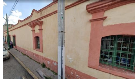
Imagen 3: Fachada Este. (Google Maps, 2020)
