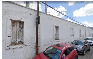
Imagen 8: Fachada Oeste. (Google Maps, 2020)
