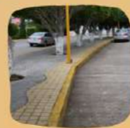
VISTA 1 NIVEL DE BANQUETA
