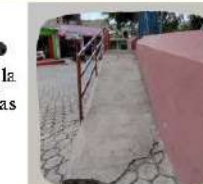
VISTA DE LA RAMPA DEL ACCESO PRINCIPAL
