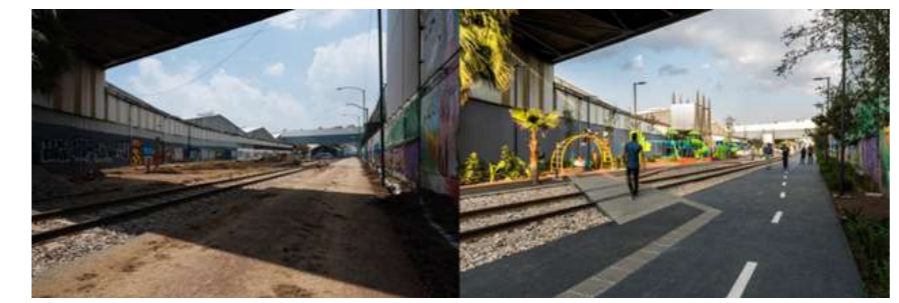
Ilustración 192: Antes y después de la intervención. FUENTE: Arturo Arrieta, 2017.
