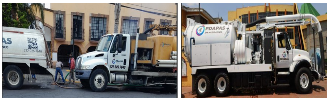
Figura 58. Medidas que el municipio de San Mateo Atenco realiza previa a las lluvias (Desazolve de coladera en Avenida Juárez Barrio San Nicolas, Abril de 2023.
