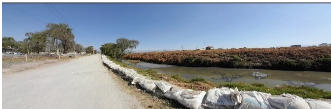
Figura 59. Orilla del Río Lerma con costales de arena Barrio de Guadalupe, San Mateo Atenco
