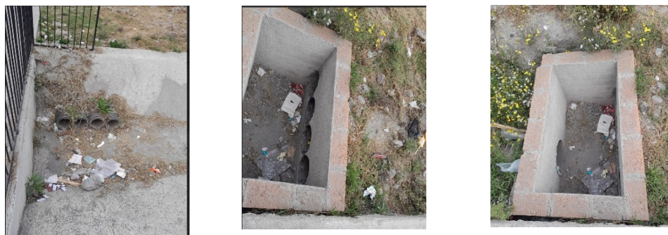
Figura15. Cárcamo y caja de inspección de aguas de lluvia en la Calle Juárez.
