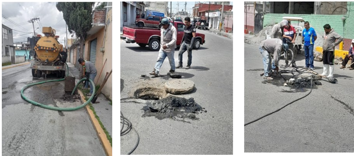
Limpieza de coladeras Av. Buenaventura, Barrio la Concepción y Av. Juárez, Barrio Guadalupe
