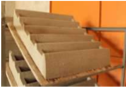
Ilustración 66: Paneles que conforman los muros, extraída de: https://www.herzogdemeuron.com/index/projects/complete-works/351-375/354-1-arena-do-morro/focus/process.html , consultado 26/03/2021
