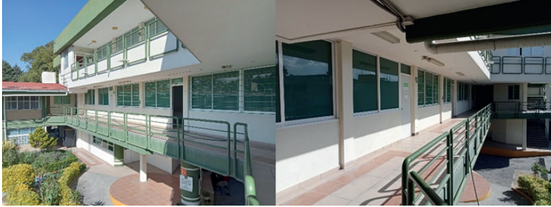
Imagen 11. Instalaciones de la FaPUR (Flores, 2023).
