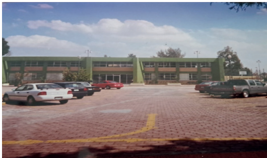
Imagen 4. Edificio B de la Facultad de Lenguas (2006). Archivo de la Facultad de Lenguas.
