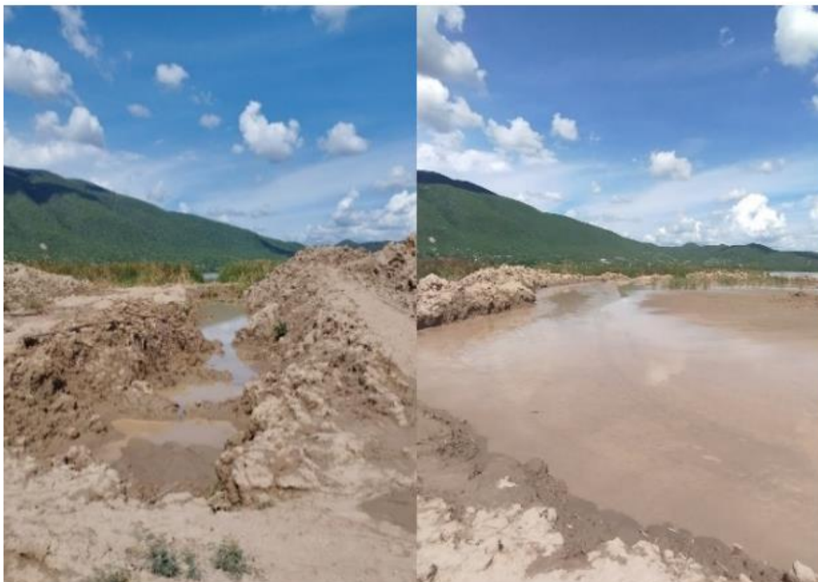
Figura 4.7 Zona de desazolve de la laguna Tuxpan
