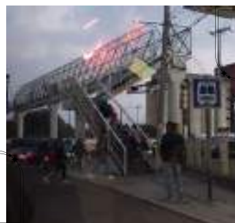
Figura 6.33: Falta de iluminación en pasos peatonales. Fotografía propia 2023
