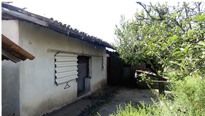
Imagen 5. Patio en la vivienda tradicional mazahua, construida en 1920
