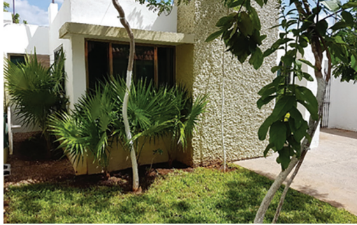
Imagen 2. Fachada de la vivienda media, estudio de caso en Mérida, Yucatán, 2021
