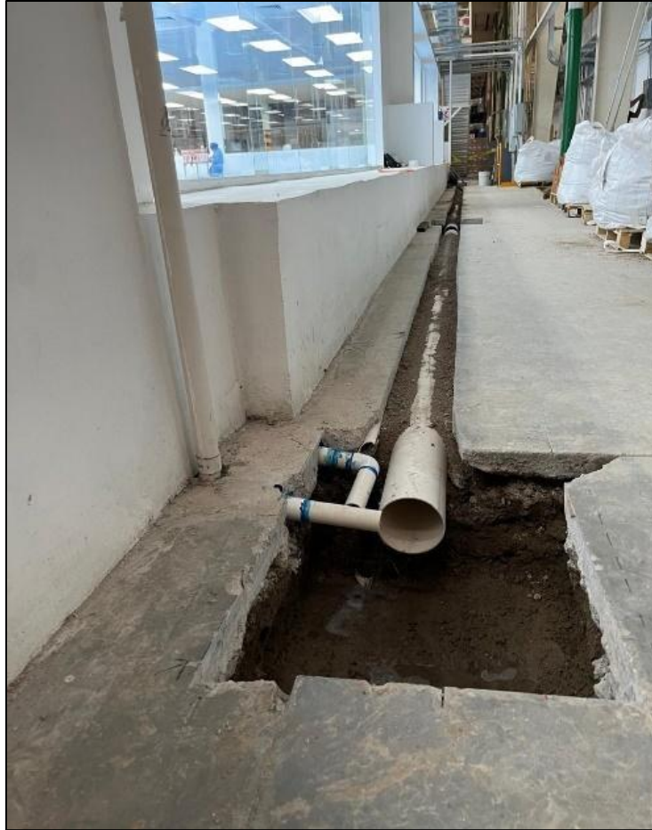
Imagen 17. Instalación de tubería de procesos.
