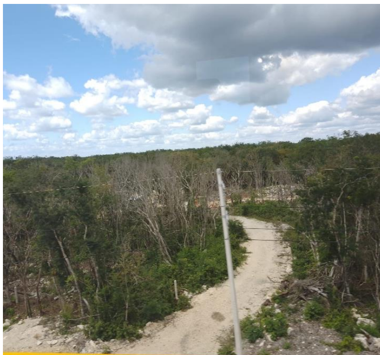
Imagen 16. Apertura de nuevos caminos para futuras urbanizaciones
