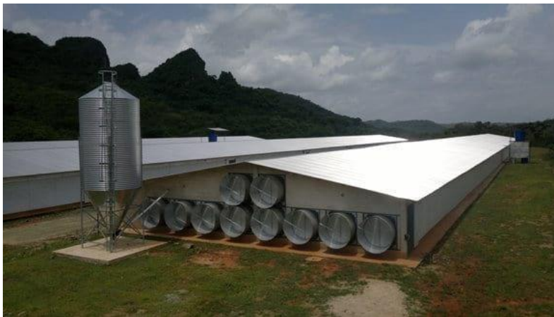
Figura 5. Caseta de ambiente controlado
