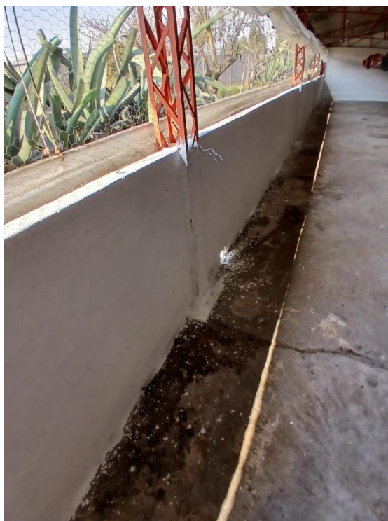
Figura 25. Encalar paredes como forma de manejo sanitario y mantenimiento de las instalaciones
