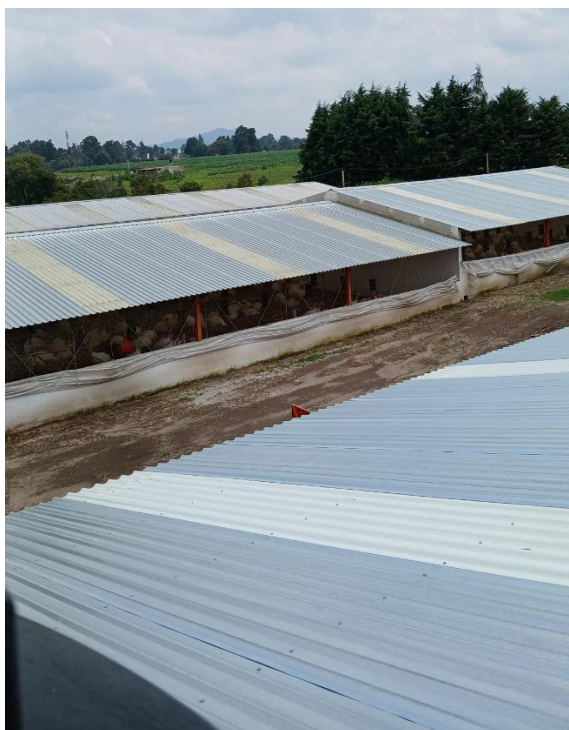
Figura 4. Distancia considerable entre casetas
